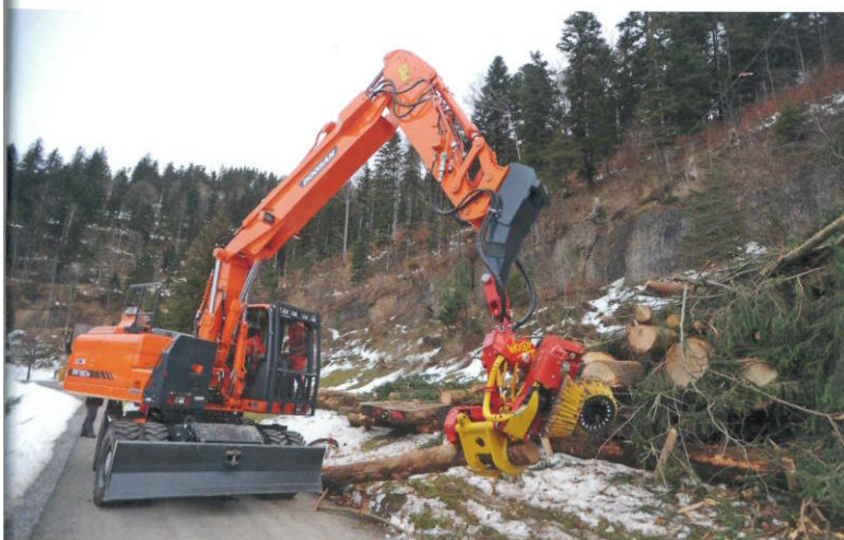
Graben, Greifen, Sägen: Nüesch & Ammann setzt den Doosan DX 190W-3 bei Holz- und Erdarbeiten ein.
